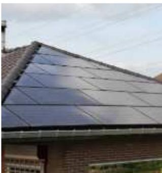
Panneaux triangulaires complétant les panneaux solaires pour couvrir la globalité de la surface de toiture
