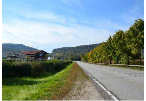
la RD1504 à Yenne, déviation est/ouest de la commune
