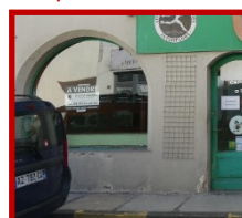
13. Baie en arcade dont l'allège est condamnée et l'encadrement chanfreiné est peint dans une teinte et une texture non adaptées.
