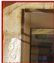
6. Pose de vitrine au nu extérieur de la façade et non en
