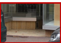
2. Seuil carrelé et vitrine posée en retrait de la façade
