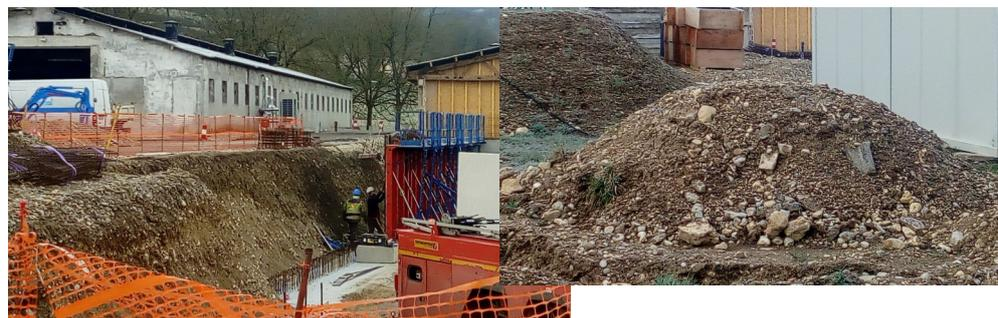
Ce sondage en grand révèle visuellement un limon graveleux, d'origine plus probablement plutôt fluvio-glaciaire. En s'éloignant vers l'ouest la matrice limoneuse fine est plus ostensible et donc moins perméable. Verticalement, un système de couches alternant graves et limons contribue à renforcer l'idée d'une meilleure perméabilité horizontale que verticale.
