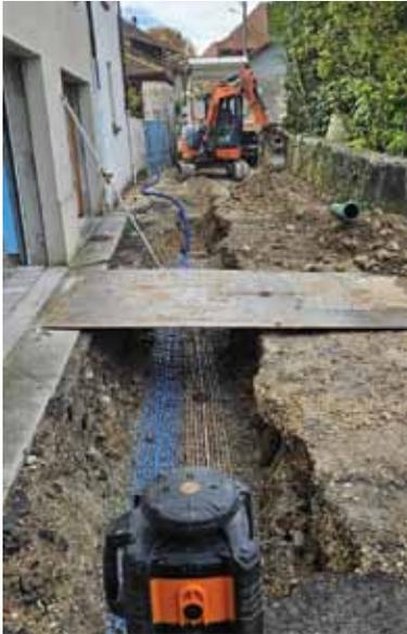
Après la fin des travaux de la Curiaz, la municipalité n'a pas tardé à engager un nouveau chantier de « mise en séparatif ». De quoi s'agit-il ? Cela consiste à créer un réseau d'assainissement pour séparer les eaux de pluie des eaux usées (salle de bains, toilettes, machine à laver...), afin d'éviter toute pollution du Rhône. Dans le même temps, cela permettra de réduire le volume d'eau traitée par notre station d'épuration, afin de réaliser des économies de fonctionnement.
