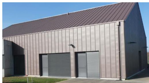
Exemple de bâtiment d'activité
