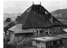
Fig. 16 Château d'Ollon (VD-CH) : Toiture de 1509-12 avant l'effondrement en 1982. (Ref. Archidoc - OLLON_01.JPG - photo Fibbi-Aeppli)
