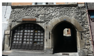
Baies en arcade fermées par menuiseries à petit bois posées en feuillure
